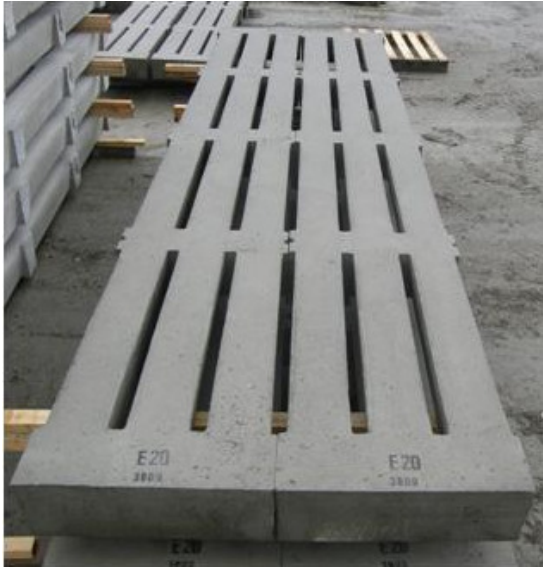
Figur 1. To 3-planks element 3,6 m lange med 3 interne tverr-ribber mellom endene.
