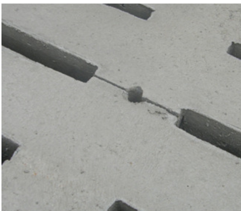
Fig 3. To element lagt på plass. Der tverr-ribbene møtes ses et hull for å fylle mørtel i utsparingen som skal gjenstøpes.
