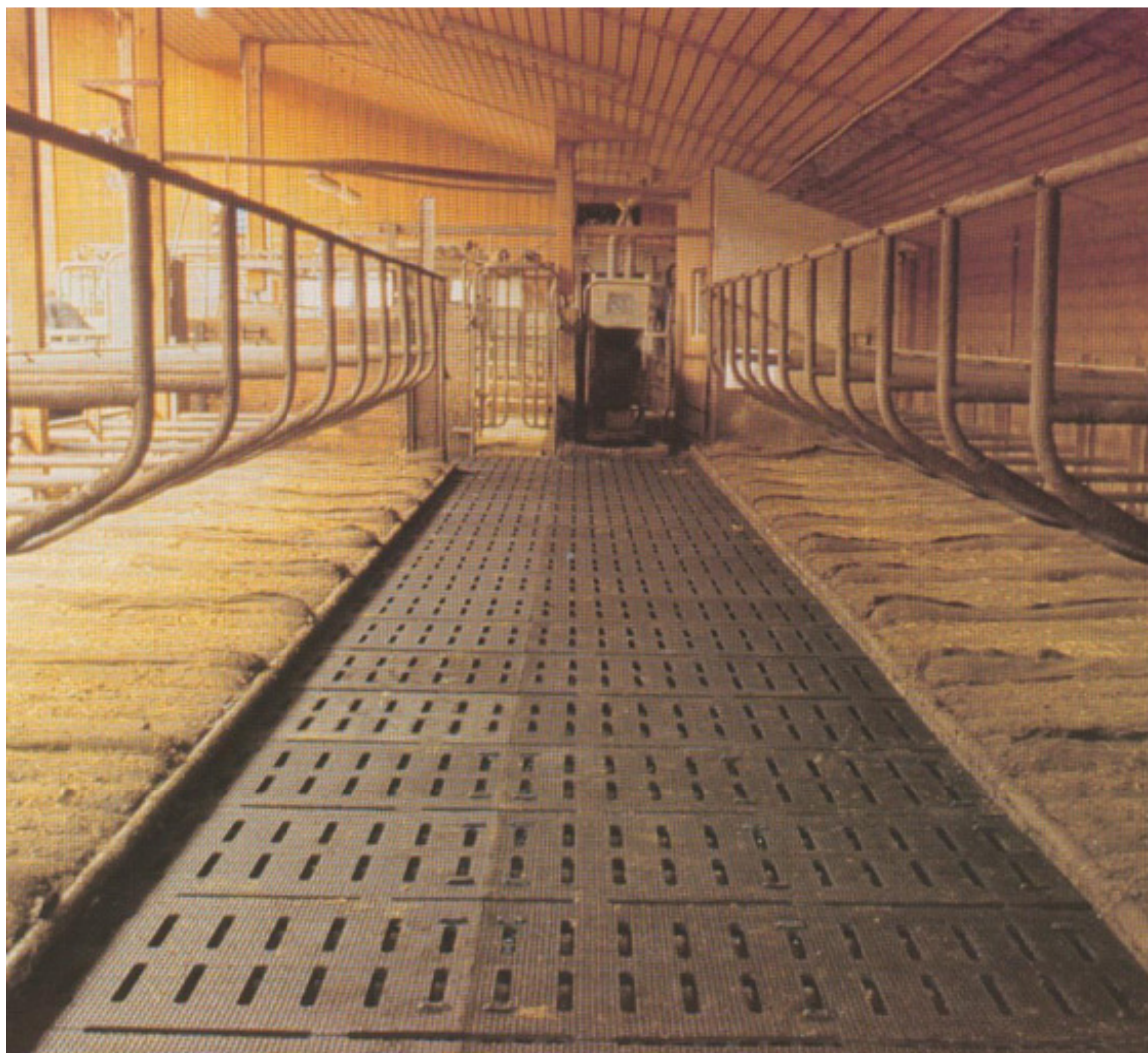
Fig. 4. Betongspaltegolv med gummibelegg (Univ. Hohenheim).
